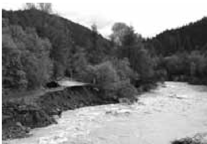
Zniszczony most na osiedlu Bulandy w Szczawie
