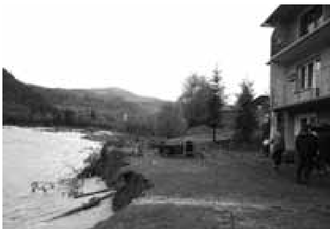
Osiedle Bulandy w Szczawie - zerwany główny kolektor
