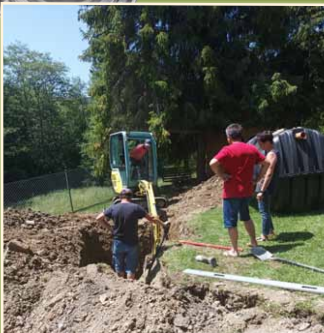
Budowa przydomowych oczyszczalni ścieków w Zalesiu
