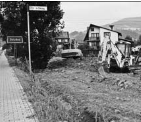
Budowa kanalizacji sanitarnej w Zbludzy
