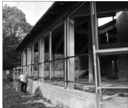
Wykonanie stolarki aluminiowej w budynku centrum turystyczno-uzdrowskiego w Szczawie
